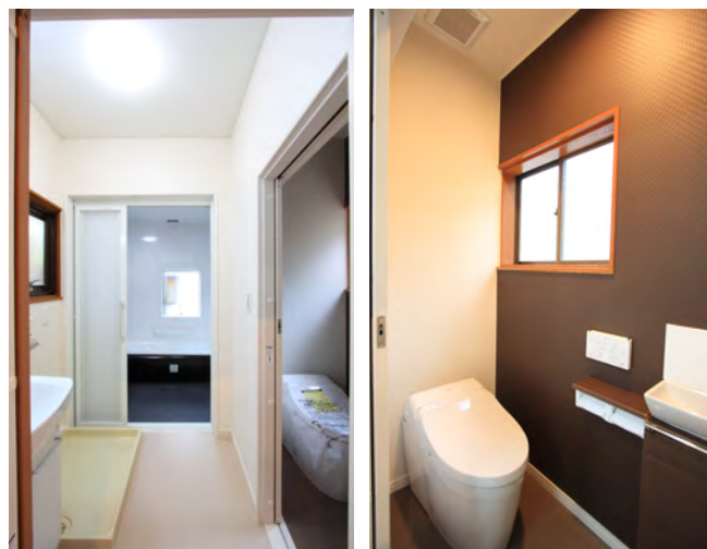
お風呂、トイレを入替えて、段差がなく利用しやすいようにリフォーム。
